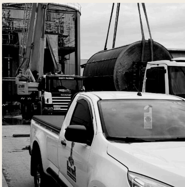
IÇAMENTO POR GUINDASTE NA PLANTA DO CLIENTE
